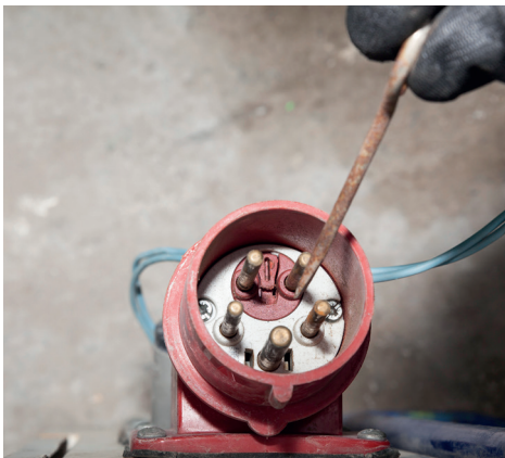
Afbeelding 2 13: Draairichting corrigeren
