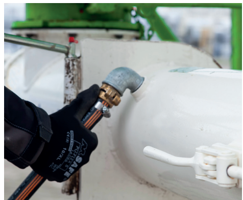
Afbeelding 2 10: Wateruitvoer
