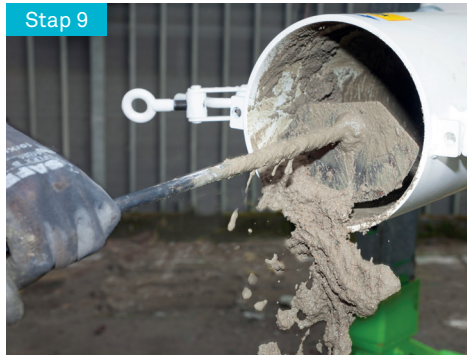
Afbeelding 2 23: Met schraper mortel verwijderen
