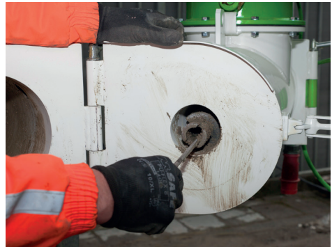
Afbeelding 2 26: Uitvijlen mortel
