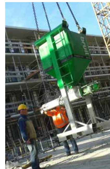
Afbeelding 2 2: Mini-silo aan hijskraan
